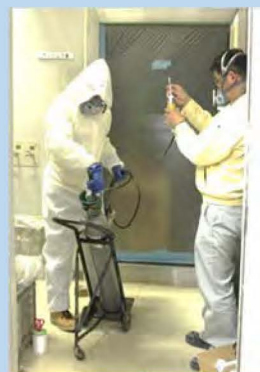
燻蒸室内をガスで満たし、酸素濃度を下げている様子▶
