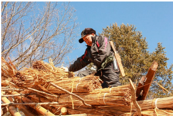
▲ 前回の修復工事の様子
